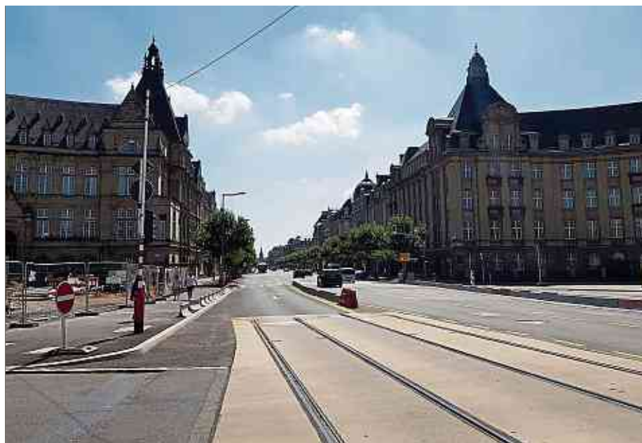
Die ersten Tramschienen wurden im Zuge der Renovierung des Pont Adolphe bis zur Place de Metz verlegt. Ende 2020/Anfang 2021 wird die Straßenbahn über die Nei Avenue fahren.
